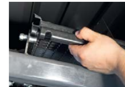
Démontage des grilles
